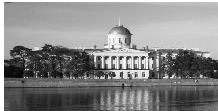
Рис. 2. Здание главной Морской таможни в Санкт-Петербурге.
